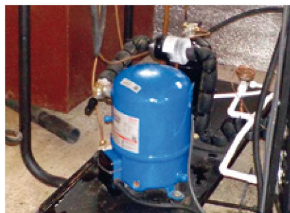
Компрессорно-конденсаторный холодильный агрегат
